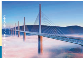
Ura më e lartë në botë – Millau Viaduct (Francë).
